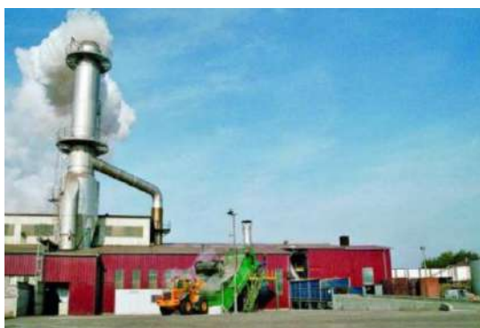
Image 1 : Vue d'ensemble de l'installation
